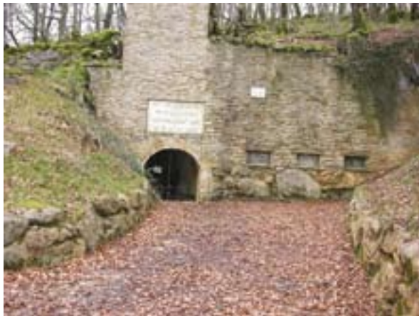
Fig. 4. Antigo muro de protección 4. irudia. Babes hesi zaharra
